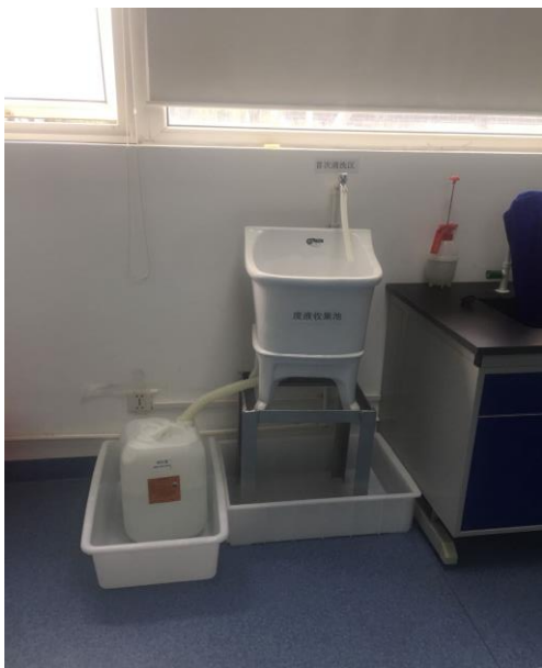
图 4-2 废液收集池及废液桶
